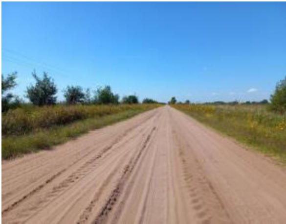
Imagen 21 – Huellones longitudinales por el paso de vehículos pesados cerca del paraje Casey
