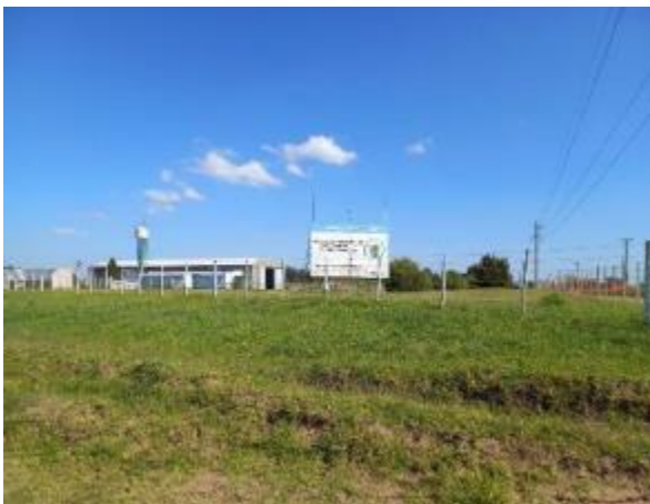
Imagen 6 – Planta de tratamiento de residuos sólidos urbanos. Km 2,20
