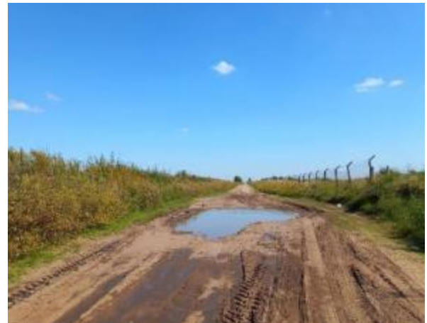
Imagen 5 – Cerco olímpico y acumulación de agua- Km 1,70
