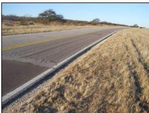
Foto. Reposición de suelo en banquina. RN N° 143, Km 17,30
