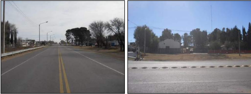
Fotos. Obras Complementarias en Travesía Urbana de General Acha
