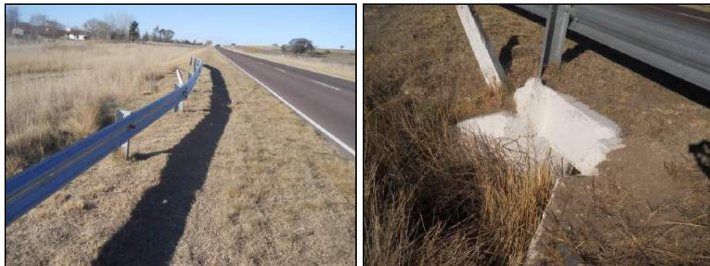
Foto. Prolongación alcantarilla transversal. RN N° 152, Km 23,48
