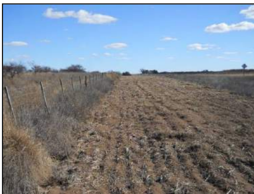
Foto. Limpieza del terreno adyacente a los alambrados
