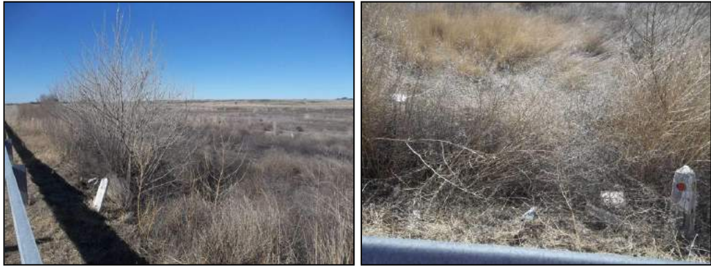
Foto. Limpieza y reperfilado de canal de desagüe. RN N° 152, Km 18,87
