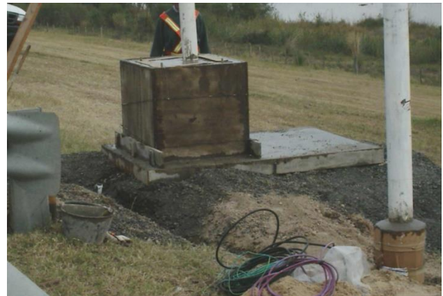
Vista de la base y el dado de H°
