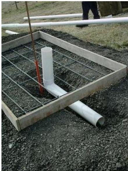
Vista base: encofrado, armadura, caño y jabalina
