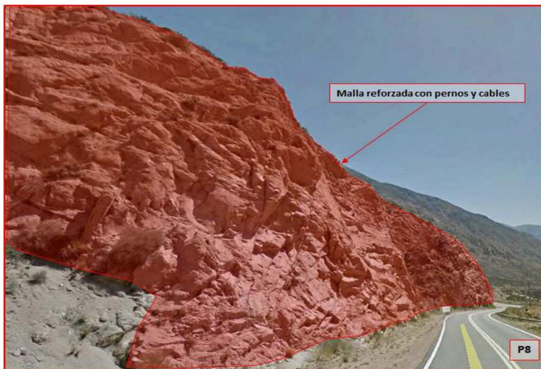
Figura22: Esquema de protección de laderas propuesto para el contratualud P8.
