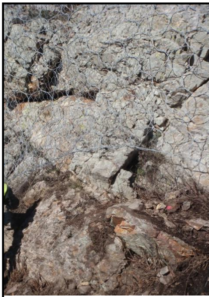
Figura 1: Estabilización con red de anillos en taludes en roca
