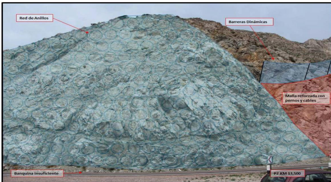
Figura 18: Esquema de protección de laderas propuesto para el contratallud P7.
