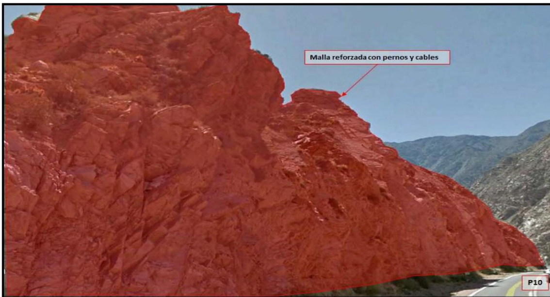
Figura 26: Esquema de protección de laderas propuesto para el contratualud P10.
