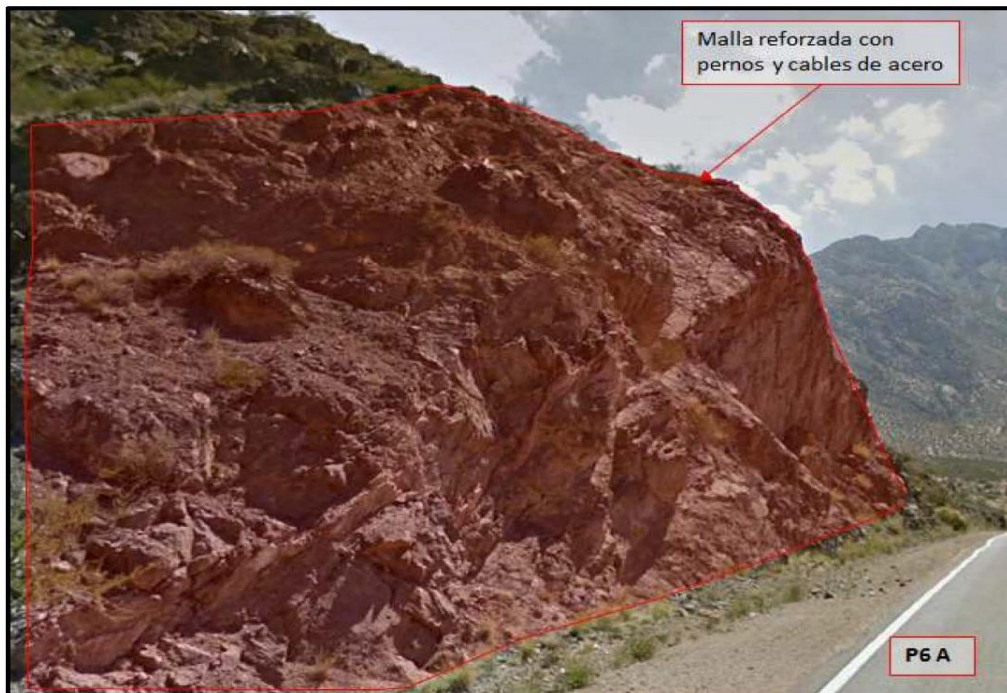
Figura 15: Esquema de protección de laderas propuesto para el contratalud P6A.
