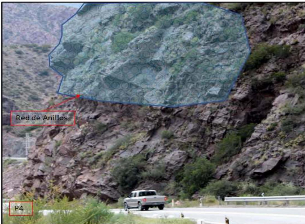
Figura 9: Esquema de protección propuesto para el contratalud P4.
