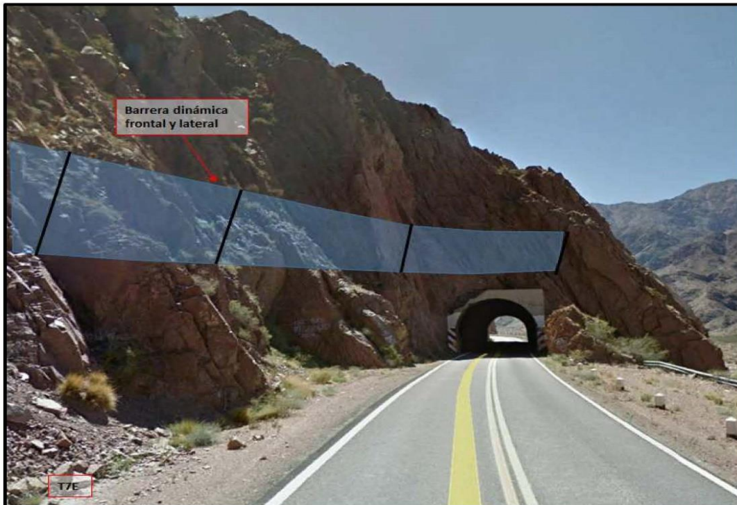
Figura 44: esquema del sistema de protección propuesto para el portal entrada del túnel 7.
