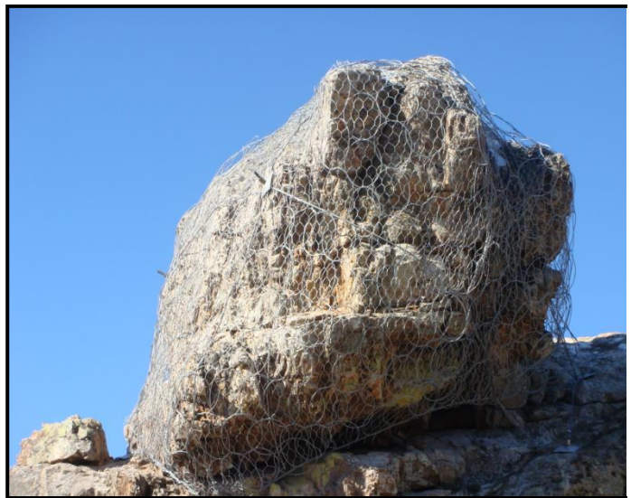
Figura 2: Estabilización con red de anillos en salientes de roca
