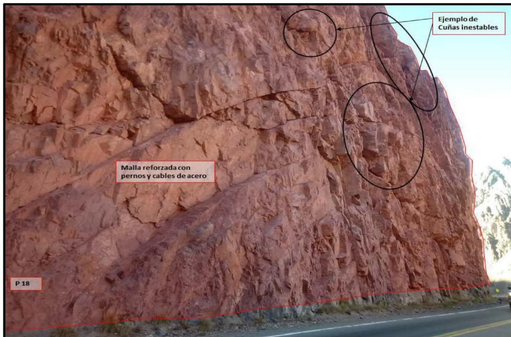
Figura 65: Esquema de protección de laderas propuesto para el contratallud P18.
