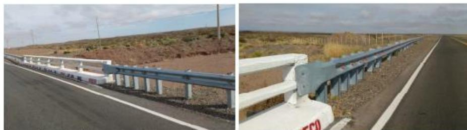
Vinculación y transición entre defensas de accesos y puente – Puente s/cañada – RN N° 237 Km 1342
